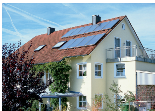
Résidentiel sur toiture
